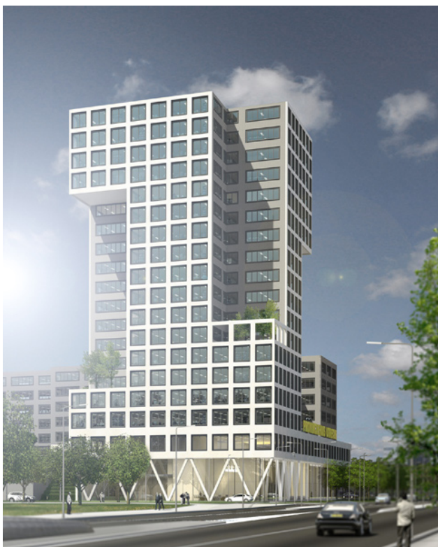
De toren en de laagbouw aan het Taatsenplein vormen het Provinciehuis Utrecht.
