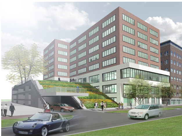
Fase 1, het zuid-westelijke gebouw. Het hele complex is gefaseerd uit te voeren, waarbij de parkeergarage telkens goed blijft functioneren.
