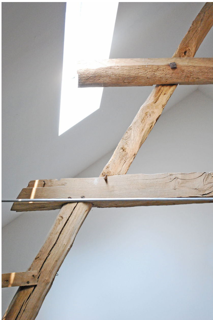
De oude spantconstructie steekt in de opening van het dakraam
